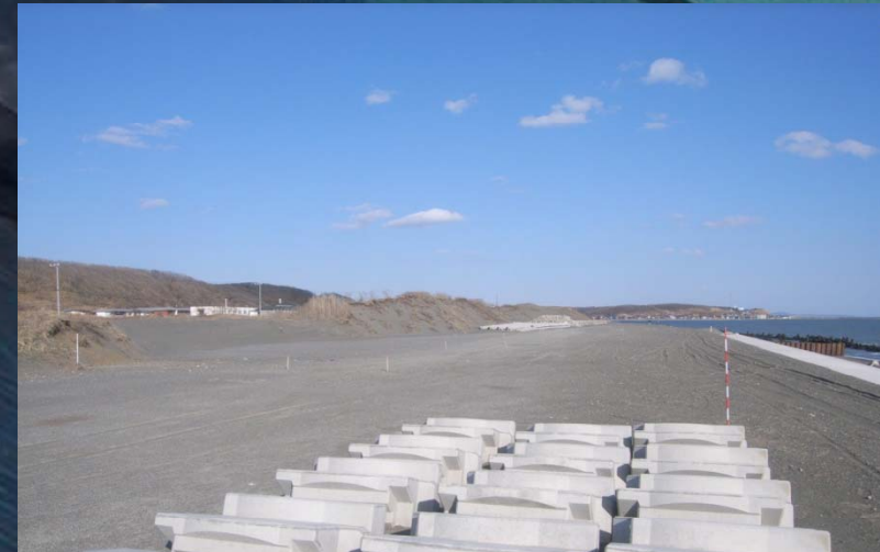
製作ヤード: 着工前状況
